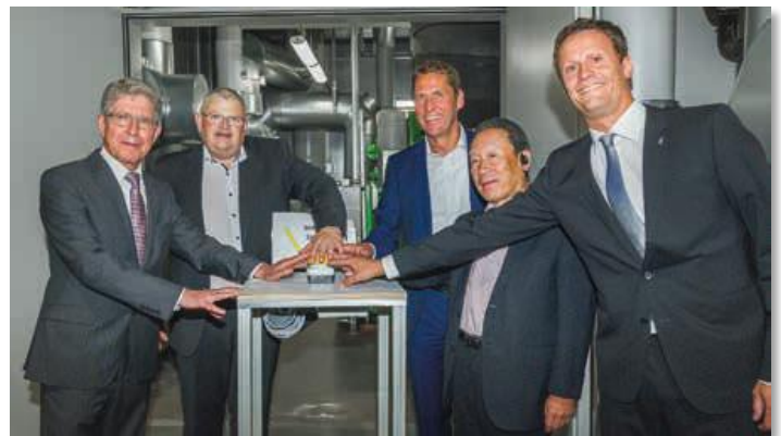
Startschuss für die Inbetriebnahme des Blockheizkraftwerks am 29. Juli 2016 (von links): Lahrs Oberbürgermeister Wolfgang G. Müller, Werksleiter Hans-Martin Souchon, GROHE-Vorstandsmitglied Thomas Fuhr, Ryuichi Kawamoto vom Mutterkonzern LIXIL und Tobias Maurer, geschäftsführender Gesellschafter der Firmengruppe Maurer
